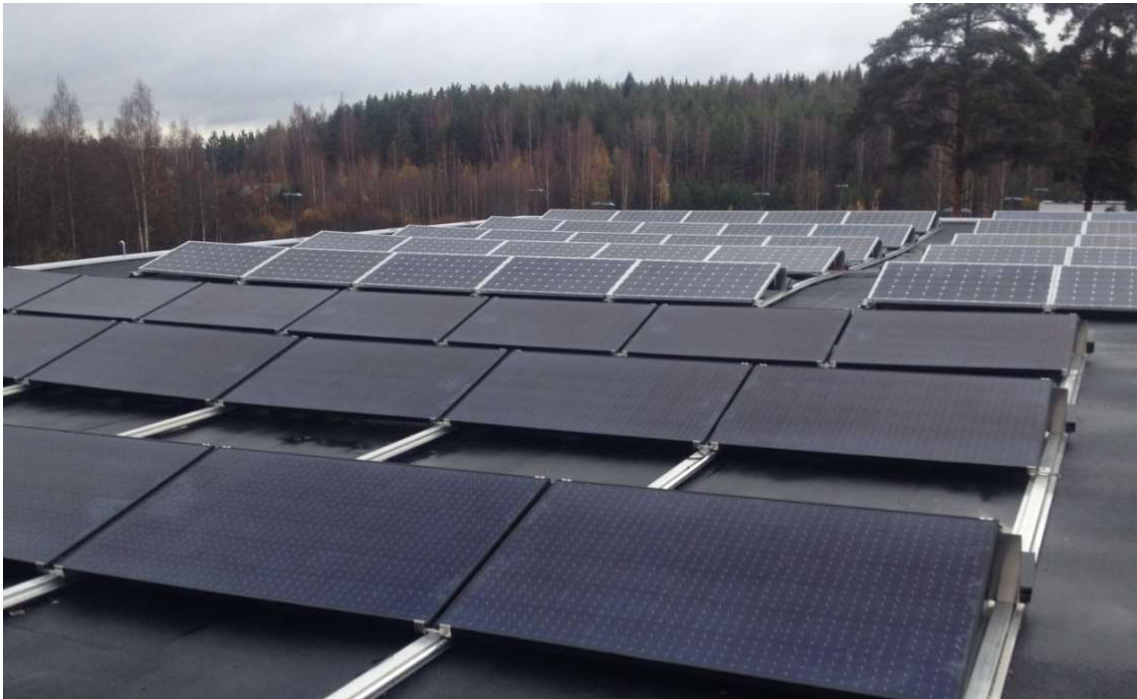
Kuva 3. Aurinkopaneelien kattoasennus (Aurinkovirta.fi 2020).
