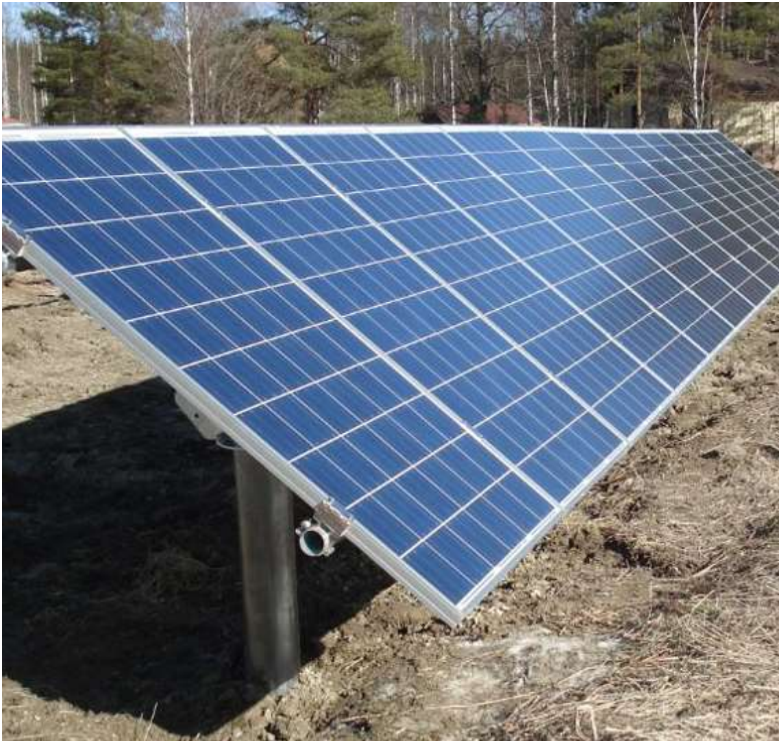
Kuva 5. Aurinkopaneelit maa-asennuksena (Finwind 2020b).
